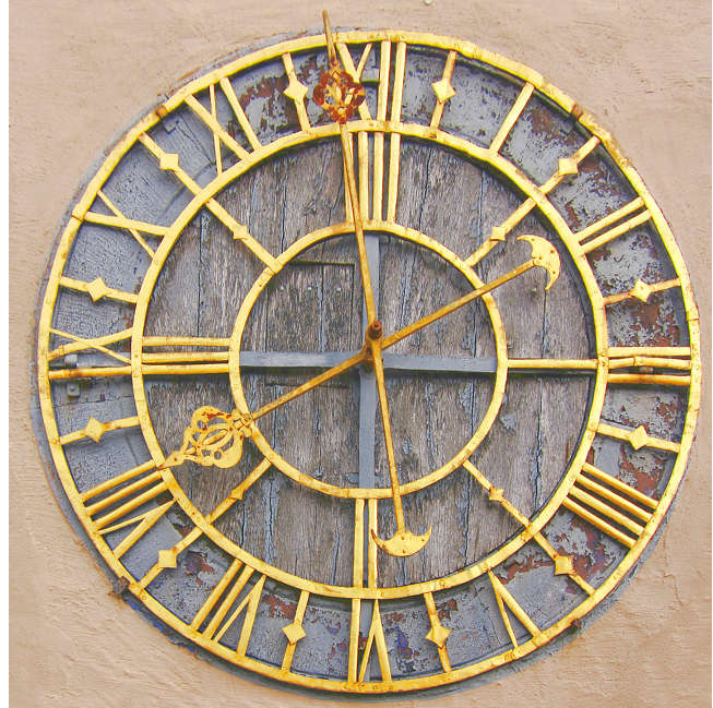
Abb. 9 Vorzustand Uhr Nr. 01 (Südseite) Turmuhr am Rathaus Ettlingen, KA
