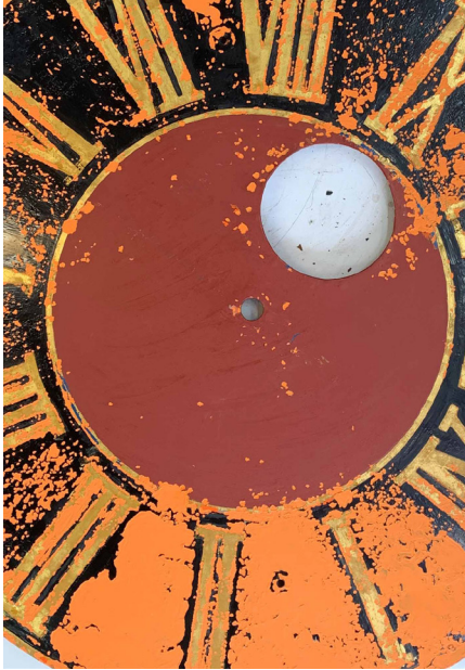
Abb. 5+6 Orangefarbene Grundierung in den Fehlstellen; Vergoldung der "V" Vorzustand; Vergoldung der "V" Nachzustand, Jakobuskirche in Jagsthausen
