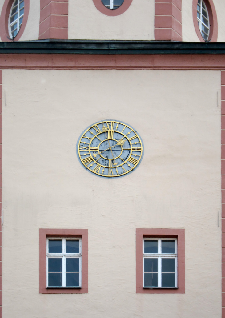
Abb. 7 Vorzustand (Südseite) Turmuhr Rathaus Ettlingen, KA
