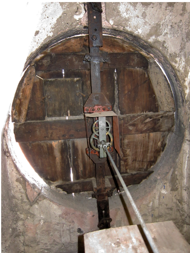
Abb. 8 Innenansicht der hölzernen Platte und der Uhrtechnik (Nordseite), Turmuhr am Rathaus Ettlingen
