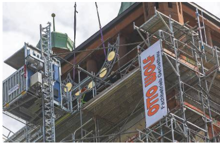
Hoch droben bringen Experten die ausladende Fracht in Position.
