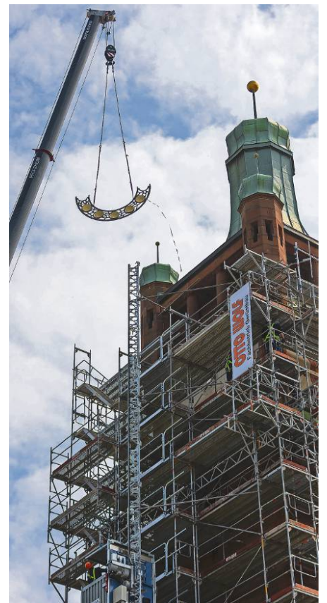
Der Arm des Autokrans hat eines der insgesamt vier Teile der beiden Zifferblätter des Bezirksamtsturms an der Angel. FOTOS: RÖHR
