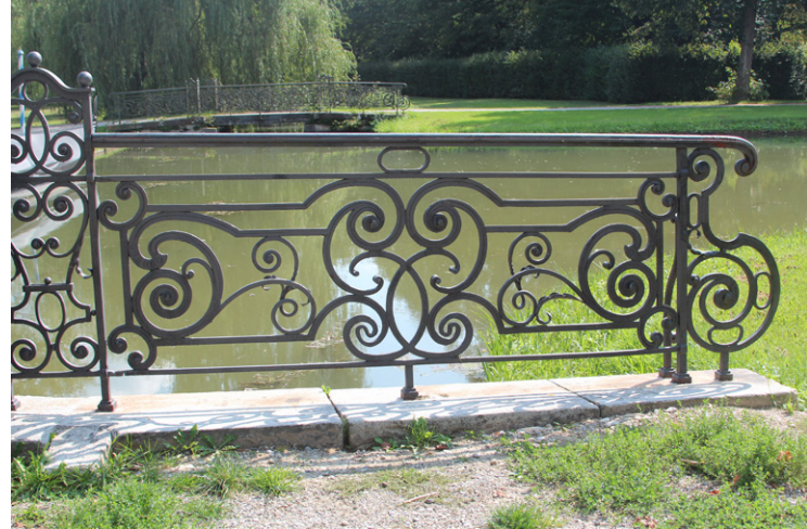
Abb. 5 Beispiel Historismus-Brückengeländer: Vorzustandserfassung
