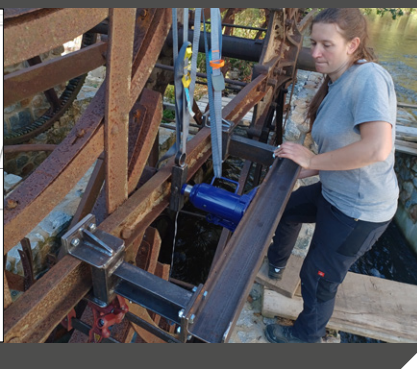
Abb. 3+4 CAD-Planung zur Rekonstruktion eines Mühlrads und Muster- rückformungsversuche
